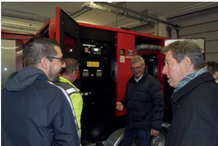
Das Aggregat der **Fa. Hartner** aus Forchdorf, das auf einem eigens angefertigten Anhänger aufgebaut wurde, damit es im Krisenfall mobil zum Einsatz kommen kann, liefert eine Leistung von max. 90 kVA / 72,0 kW.
